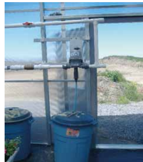
Miscelazione additivi per orticoltura Additive mix system in horticulture
